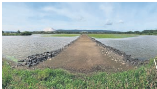
Der Damm ist fertig: Im Hintergrund ist der Bewuchs mit Seekannen zu sehen.
